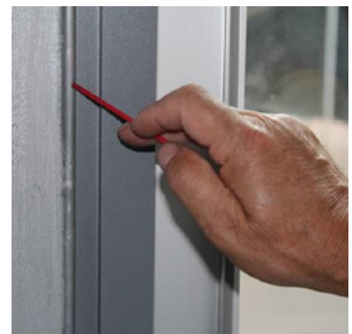
[e] Inspekcja uszczelek gumowych EPDM
