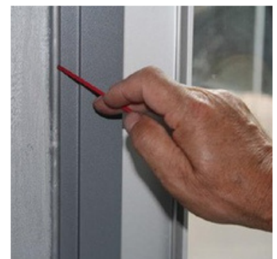
[e] Inspekcja uszczelek gumowych EPDM
