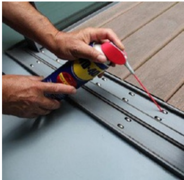
[a] Smarowanie łożysk
